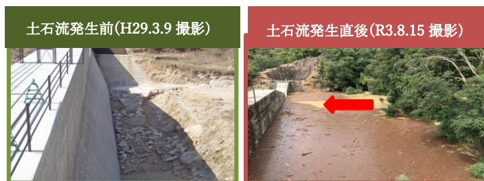
写真3 鳥越川1号砂防堰堤（土石流の捕捉前後） （写真：国土交通省 広島西部山系砂防事務所提供）
