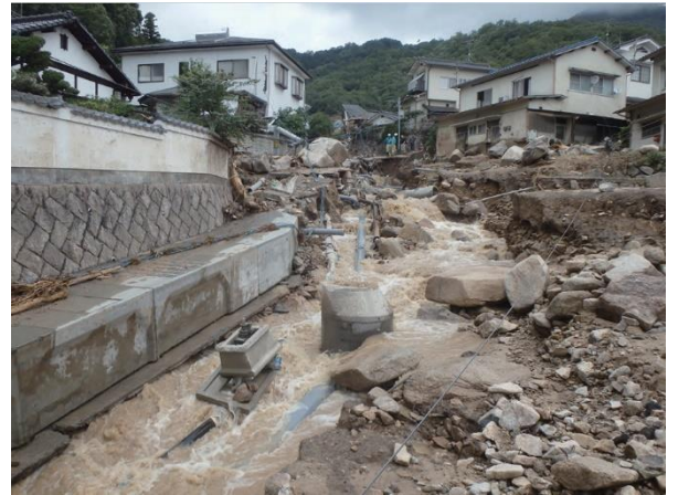
写真1 広島土砂災害の状況 広島市安佐南区 緑井八丁目付近の被災状況（市道が流出）
