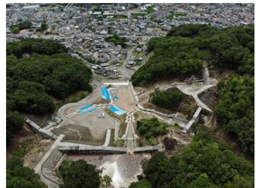
写真4 土石流を捕捉し、下流域の 住家を守った鳥越川1号砂防堰堤 （写真：国土交通省 広島西部山系砂防事務所提供）
