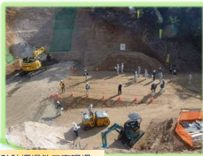
溪流砂防堰堤外工事現場
