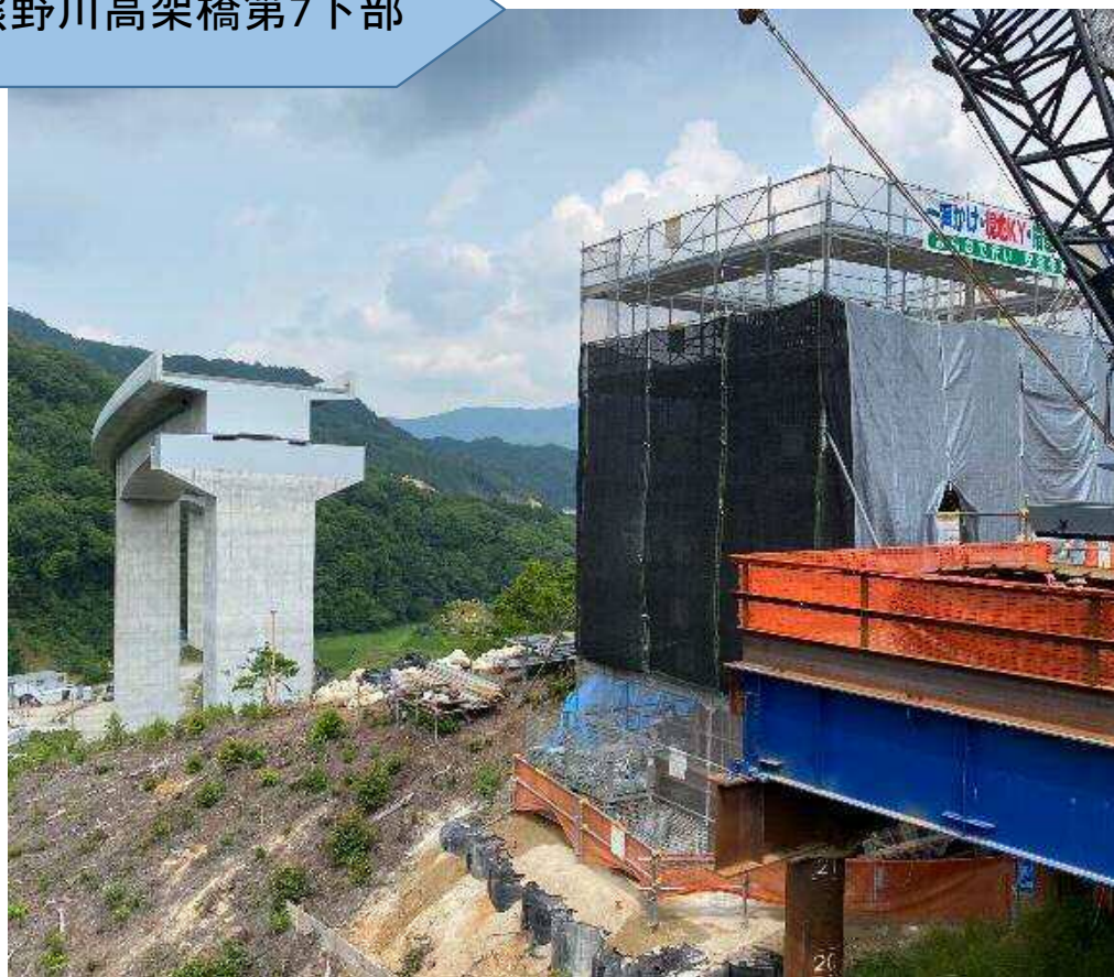
熊野川高架橋第7下部
